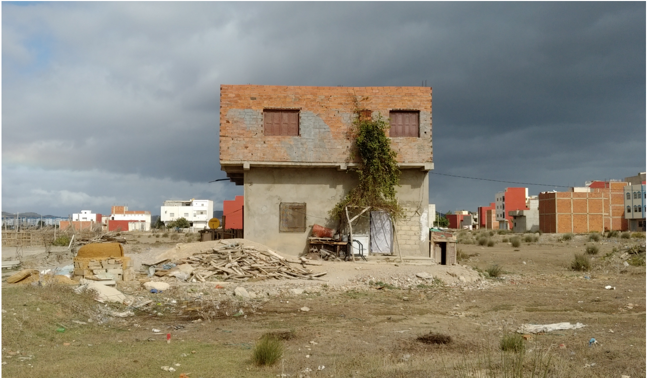
La ville marocaine en construction_ exemple de « matériau urbain » (le bloc)_photo TdA
