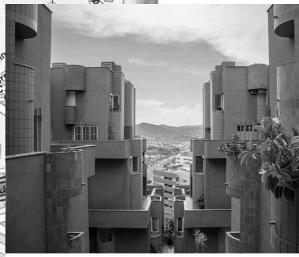
02. WALDEN 7 !! Carretera Reial, 106, 08960 Sant Just Desvern
