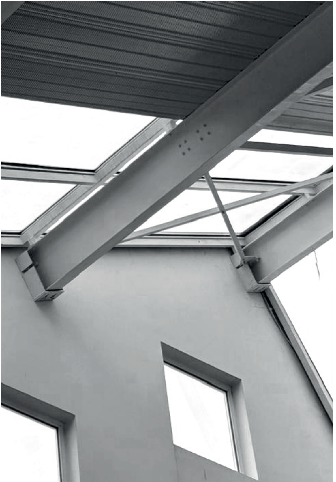
Fraicheur insufflée - Bassins à flot
