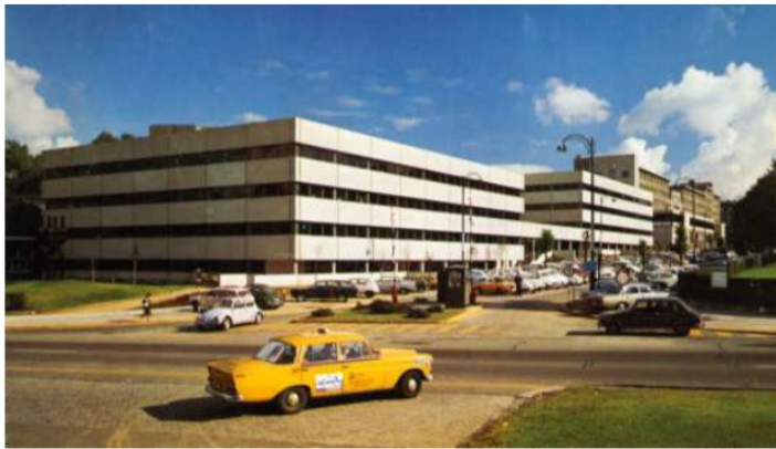
Image au moment de la construction
