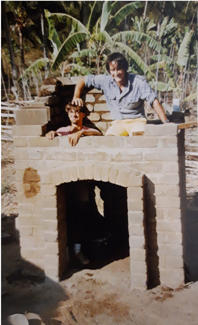
Chantier d'un prototype en BTC, début des années 1980, photo non datée, ©CRATerre
