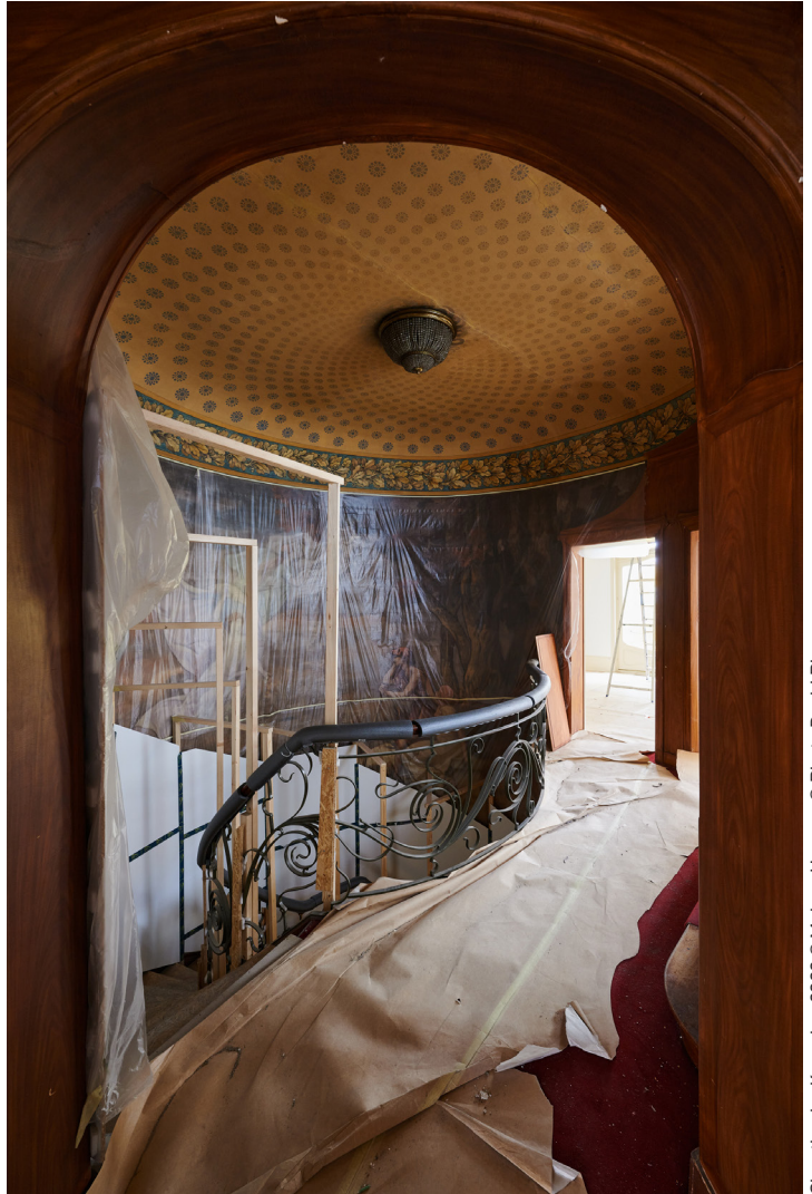
Chantier de décembre 2022 © Maison Hannon © Photo David Plas
