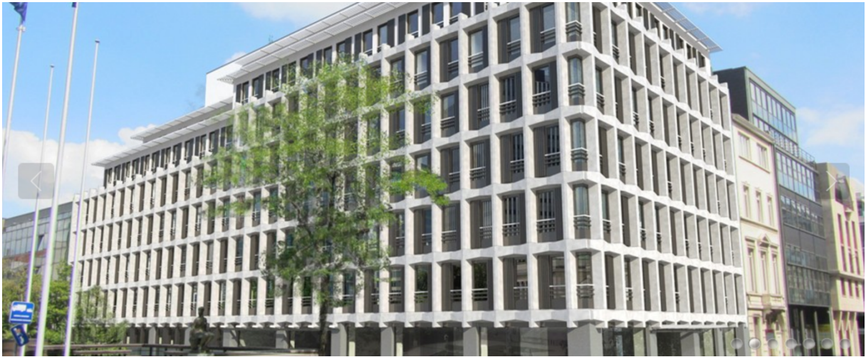
Reconversion, ni vu ni connu, d'un immeuble de bureaux en un hôtel avec rez-de-chaussée actif, rue Joseph II
